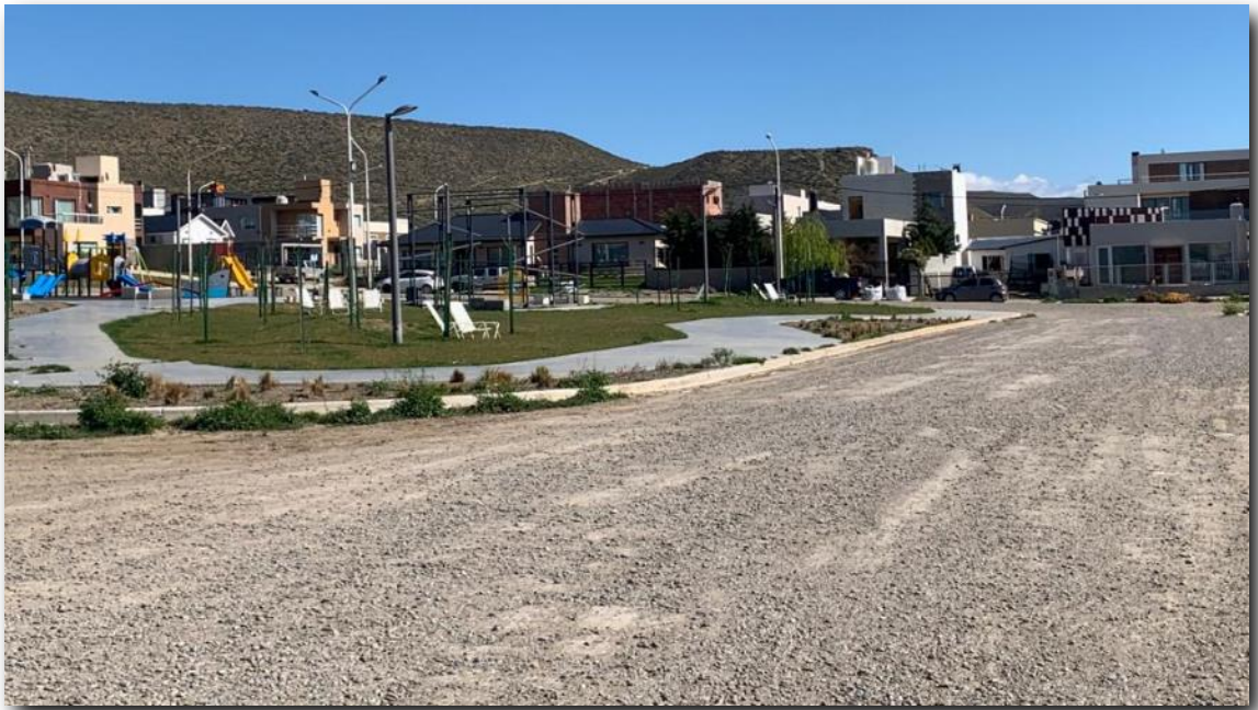
Figura N° 24: Calle Faro San Gregorio – Sector 8
