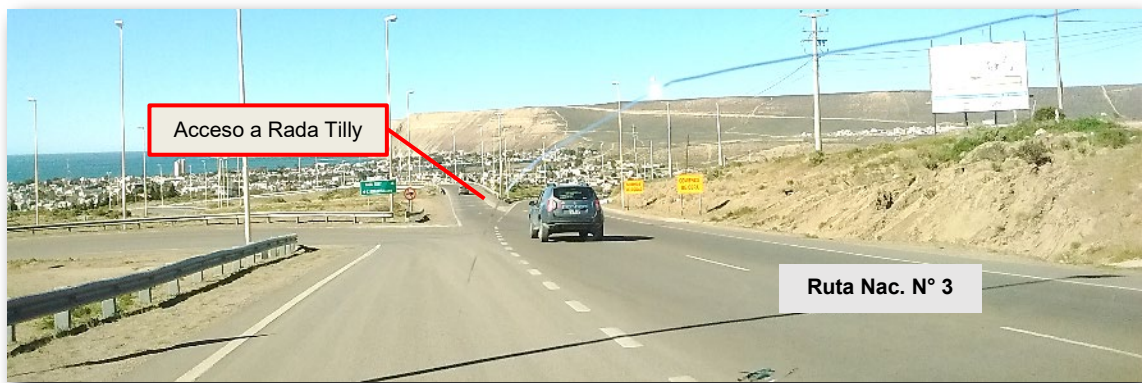
Figura N° 2. Acceso principal a la localidad de Rada Tilly dirección N-S por Ruta Nacional N° 3.
