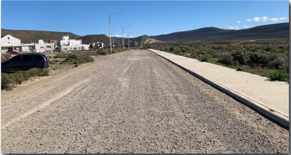
Figura N° 23: Calle Faro Punta Bajos – Sector 8
