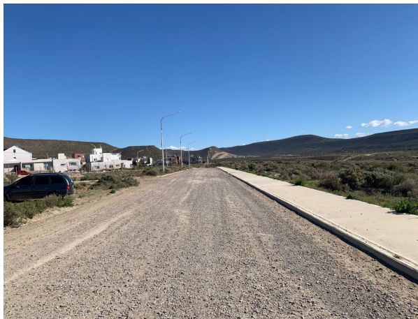
Calle Faro Punta Bajos – Sector 8
