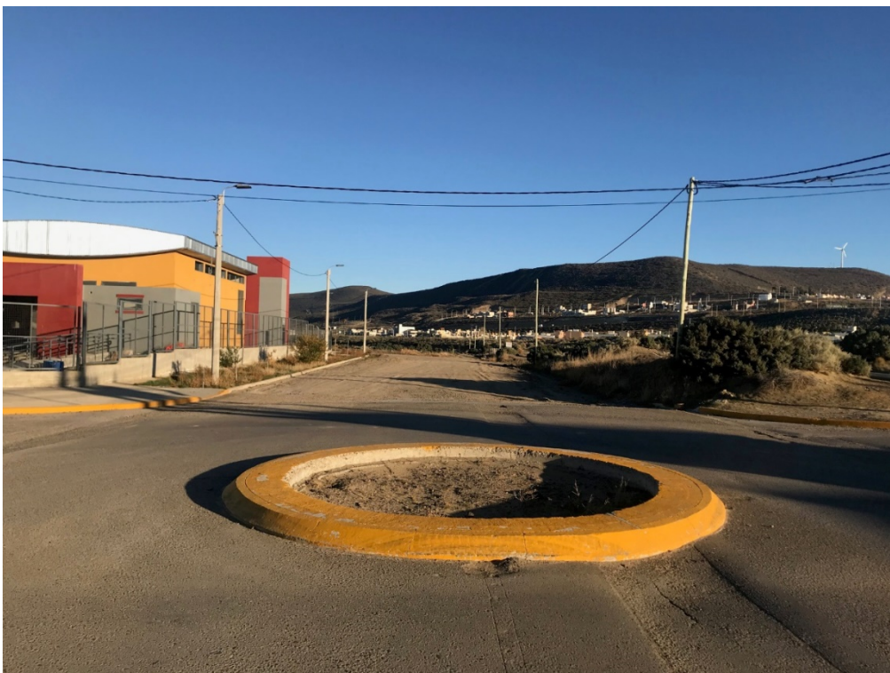
1-SOBRE AVENIDA BERGANTIN BELGRANO INTERSECCION CON ROTONDA DE AVENIDA ONAS, HACIA LA LAGUNA
