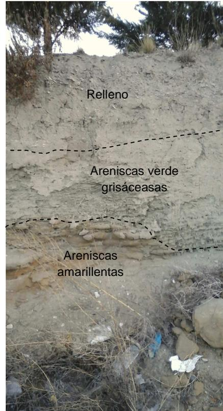
Figura 27: Detalle del contacto formación - relleno
